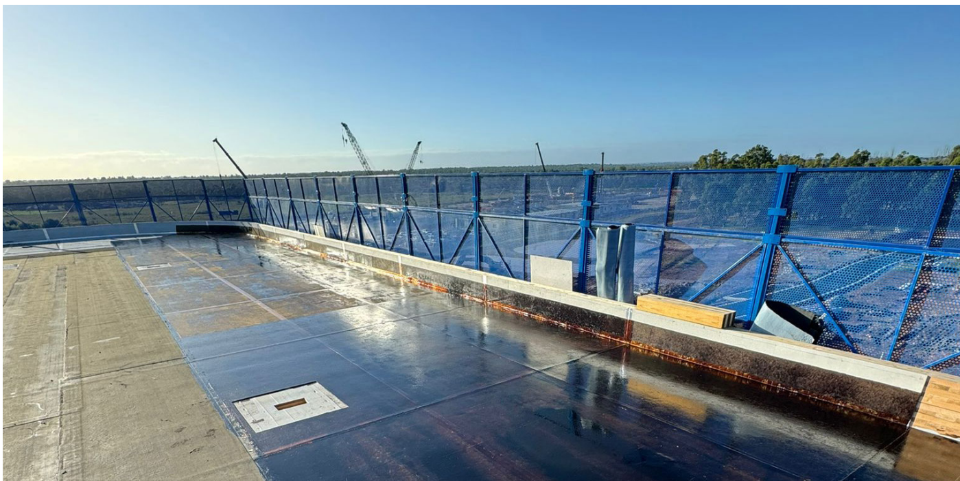
PERIMETER METAL ROOF PRIMER
