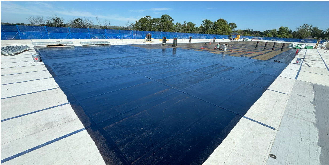
UNDER METAL ROOF PRIMER
